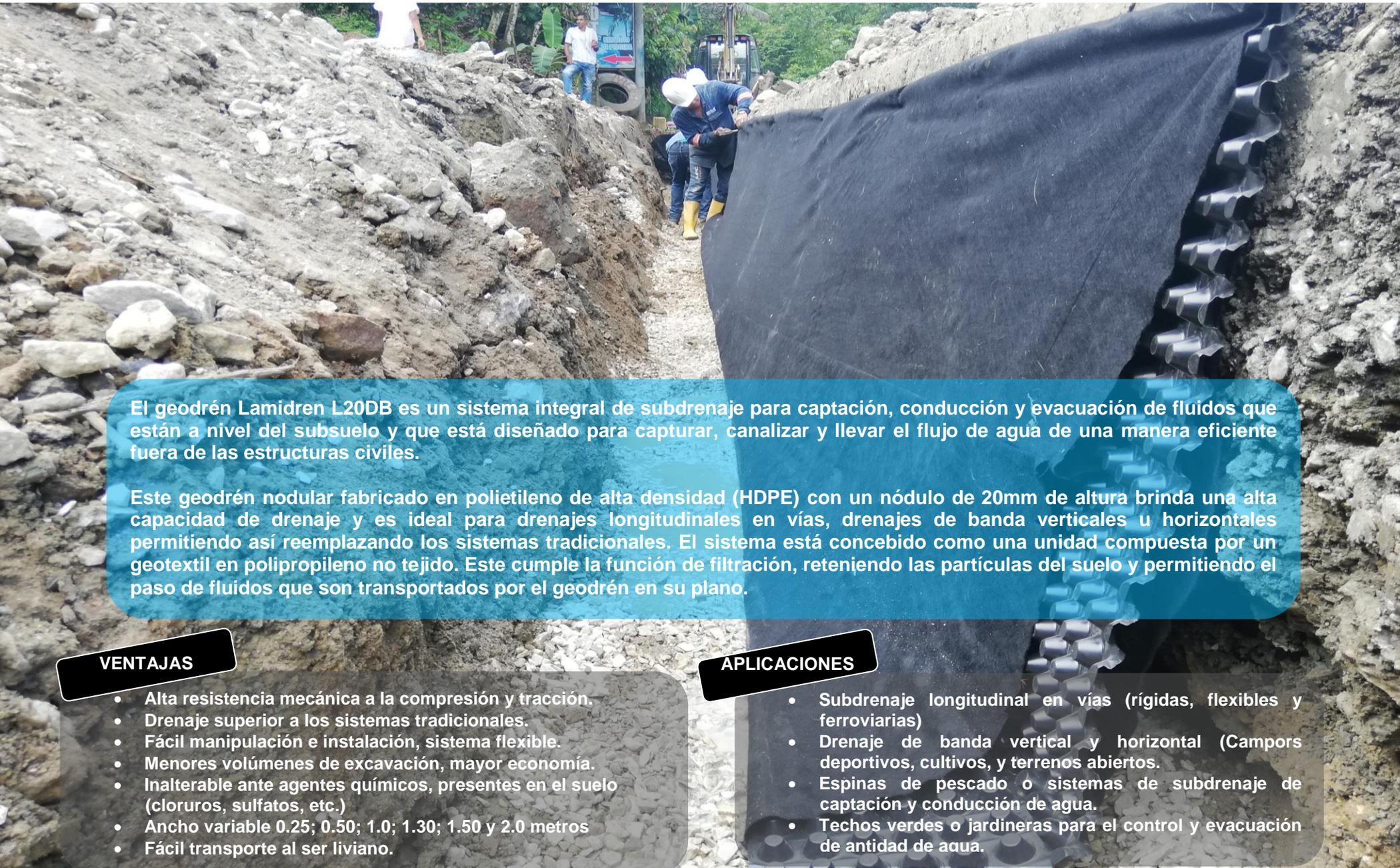
El geodrén Lamidren L20DB es un sistema integral de subdrenaje para captación, conducción y evacuación de fluidos que están a nivel del subsuelo y que está diseñado para capturar, canalizar y llevar el flujo de agua de una manera eficiente fuera de las estructuras civiles.
